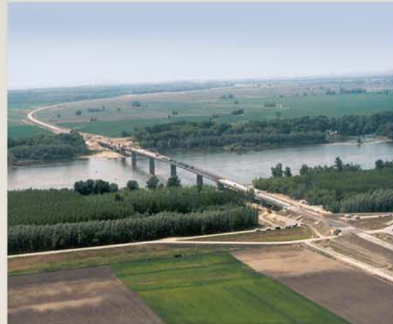
Szekszárdi Duna-híd Szekszárd Danube Bridge Donaubrücke Szekszárd
