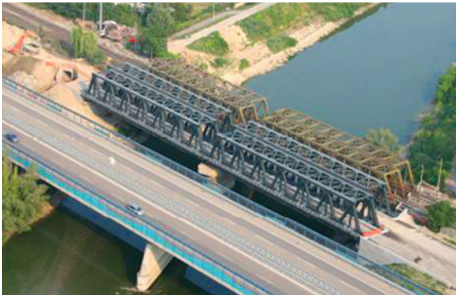
Foto 2. Il ponte sul fiume Brenta
